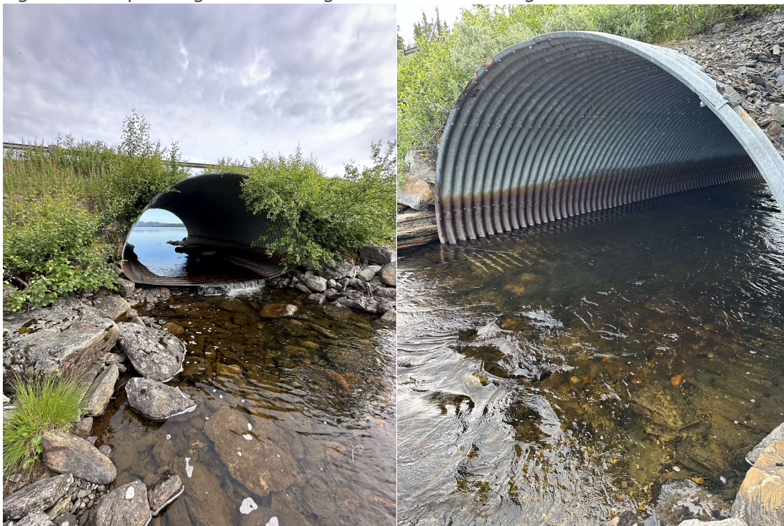
Figur 45. Vägtrumma vid utloppet och Figur 46. Vägtrumma vid utloppet.
